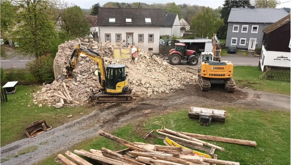
Nun, viele von Euch haben den Abriss vom „Schiwisch-Haus“ mit beobachtet. Nach dem Kauf des Hauses stellte sich schnell heraus, dass keine Rettung mehr für das Haus besteht, da sich beide Giebel von den Hauswänden mehrere Zentimeter getrennt hatten. So kam zeitnah die Entscheidung zum Abriss.
