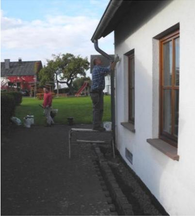
Dieser kaputte Putz wurde abgestemmt, so dass zuerst Dichtungsschlämme und dann wieder ein neuer Außenputz aufgetragen werden konnte. Schließlich wurde als letzte Schicht wieder der sogenannte „Scheibenputz“ aufgetragen.
